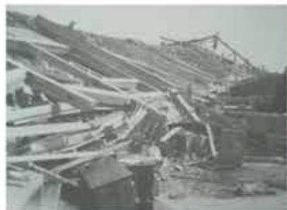
伊勢湾台風で倒壊した有田小学校
