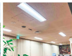
照明取替(庁舎1階ロビー)
