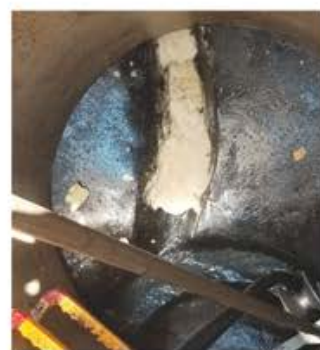
下水管清掃時の様子 (白い塊は食用油が固まったもの)
