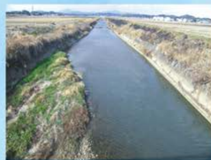
外城田川護岸整備状況 下田辺地内
