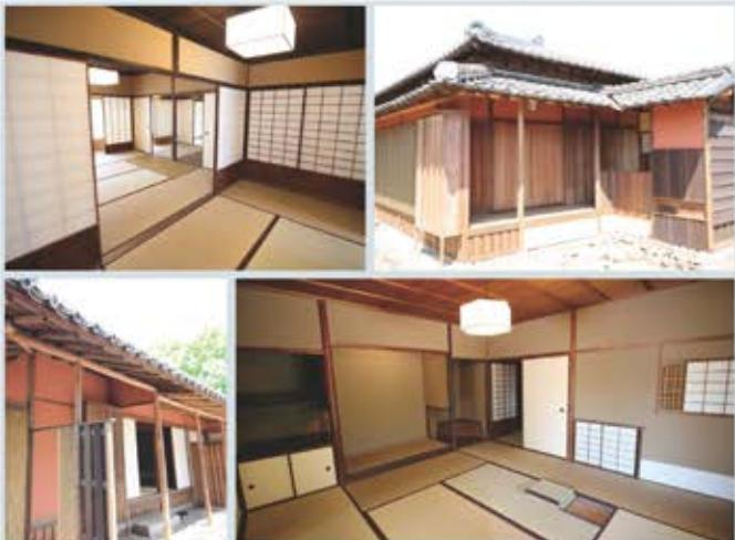
玄甲舎の修復工事が完了しました。解体するなかで判明した後世の改造は、建立当時へ戻し、建材も約8割以上再利用することで、金森得水の茶室兼別邸「玄甲舎」が蘇りました。
