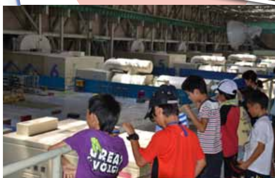
川越火力発電所
