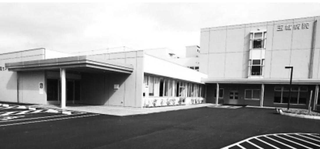
完成した健康管理センター
