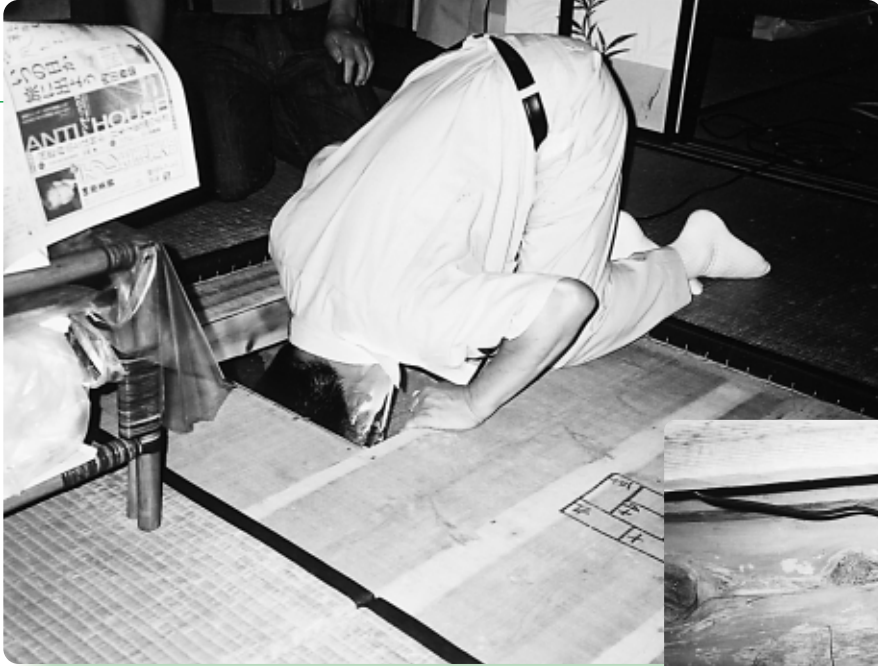
床下の点検も行われる
