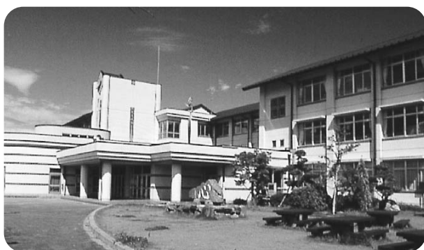
建設が予定される田丸小学校
