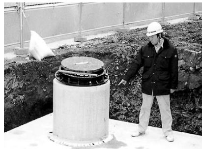
耐震性貯水槽 40トン型(板屋町)
