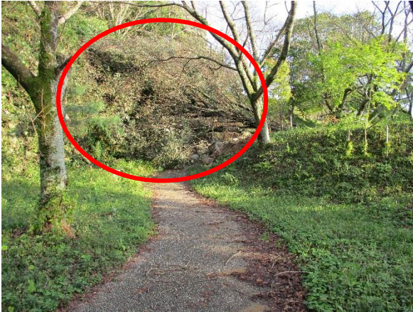
田丸城跡（遊歩道）崩落 2017年10月25日撮影(提供者：岩崎澄雄氏)
