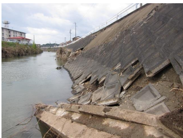
城東団地北側付近
