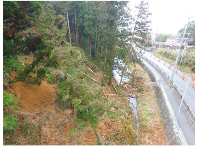
田丸土羽線田丸城跡付近(ドローン撮影) 2018年2月1日撮影(提供者：小林正弘氏)
