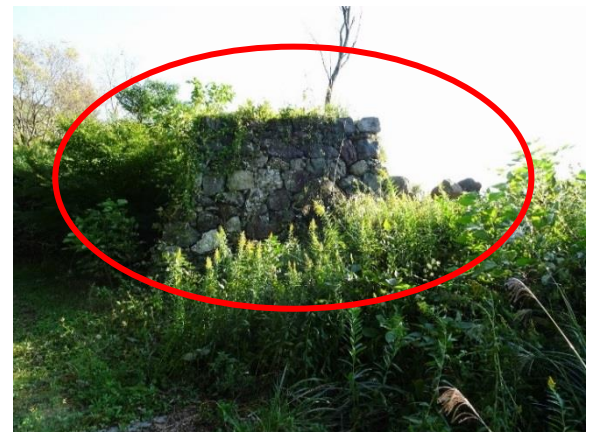
田丸城跡（北面石垣）被災後
