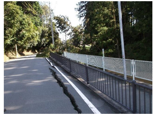
町道田丸土羽線
