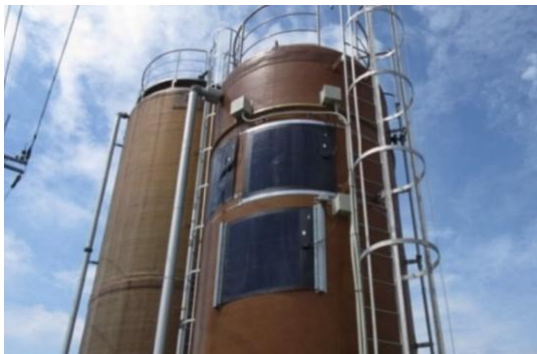
石油タンクに設置されたペロブスカイト太陽電池を活用した太陽光発電
