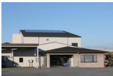
図 太陽光パネルの様子(保健福祉会館)
