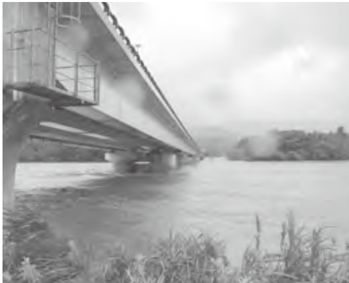
宮川の様子（岩出：伊勢自動車道 宮川橋）
