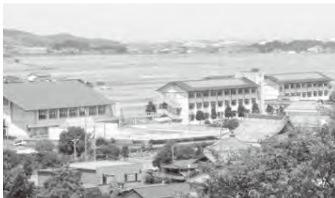
太陽光発電設備（40kW）を設置した田丸小学校
