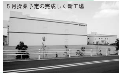
5月操業予定の完成した新工場
