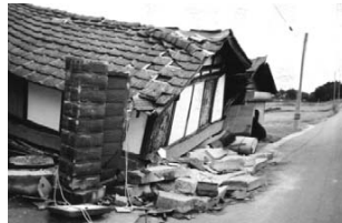
1階部分の倒壊
