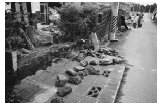
ブロック塀の倒壊
