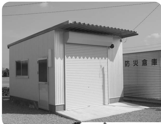
有田地区防災倉庫
