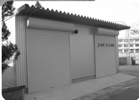
下外城田地区防災倉庫
