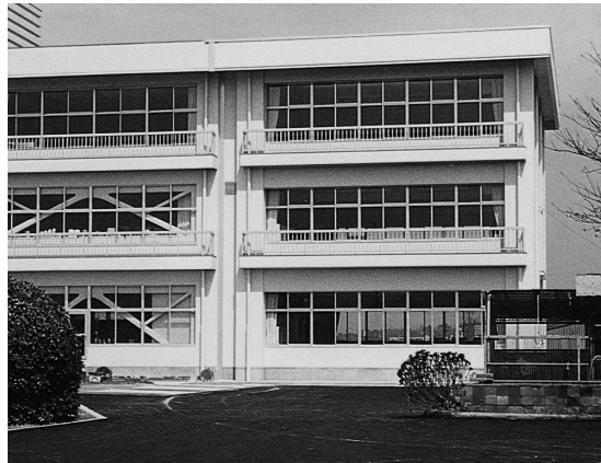
校舎東側に増築された有田小学校
